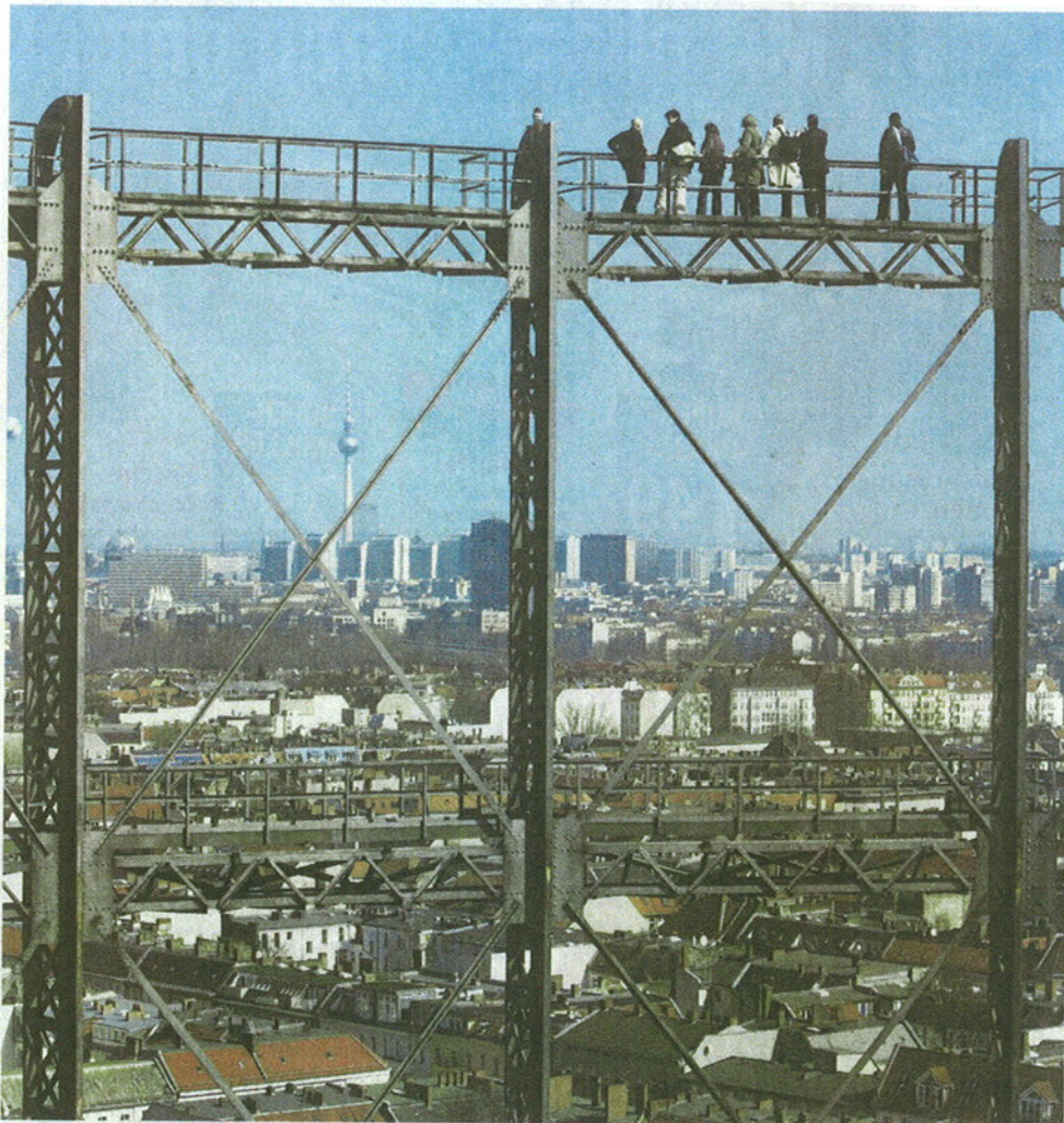
Schmaler Grat. Der Schöneberger Gasometer wird zum begehbaren Aussichtspunkt. Schwindelfrei sollte man allerdings sein, denn durch das Gitterrost unter den Füßen geht der Blick direkt in die Tiefe.
